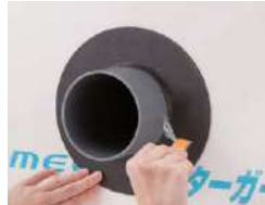
施工手順③ 内側セパレーターをはがします。
