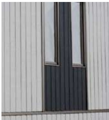
アルミモダン見切り使用 アルミモダン中間水切り使用
