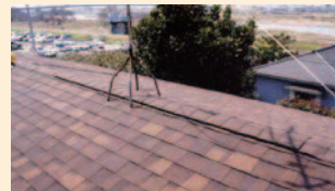
仕上げの同質棟部材や換気部材を取り付け、棟工事完成です。
