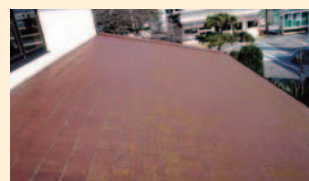
既存の屋根材は化粧スレートで、塗装を何回か繰り返しています。コケが所々に生えていました。
