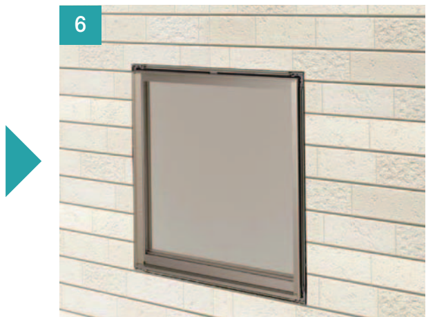
サイディング本体と「カンシキくんアルミベースN」の間はシーリング代5mmを確保します。
