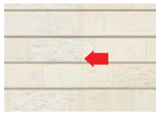
シーリングレス工法の継ぎ目
