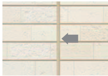
通常の工法の継ぎ目:シーリングが劣化した状態(イメージ)
