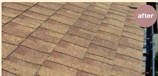
仕上げの同質棟部材や換気部材を取り付け、棟工事完成です。
