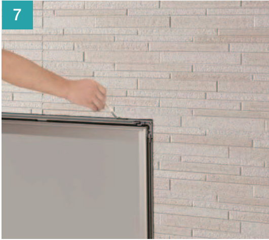
サイディング本体の切断木口にプライマーを塗布します。
