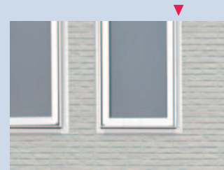
窓まわりのシーリング 目地が表に出ない
