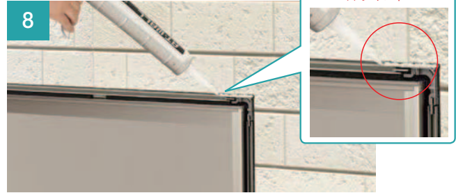
サイディング本体と「カンシキくんアルミベースN」の間に充てんシーリングを打ち、ヘラで押さえます。
