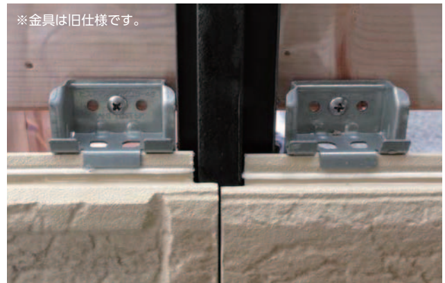
サイディング表面は濡れていますが、幅広目地 ジョイナーの室内側は濡れていません。
