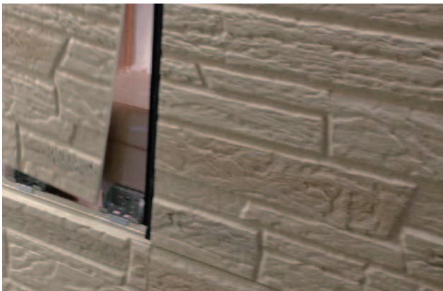
サイディングを外してみると パッキンでしっかり止水されています。
